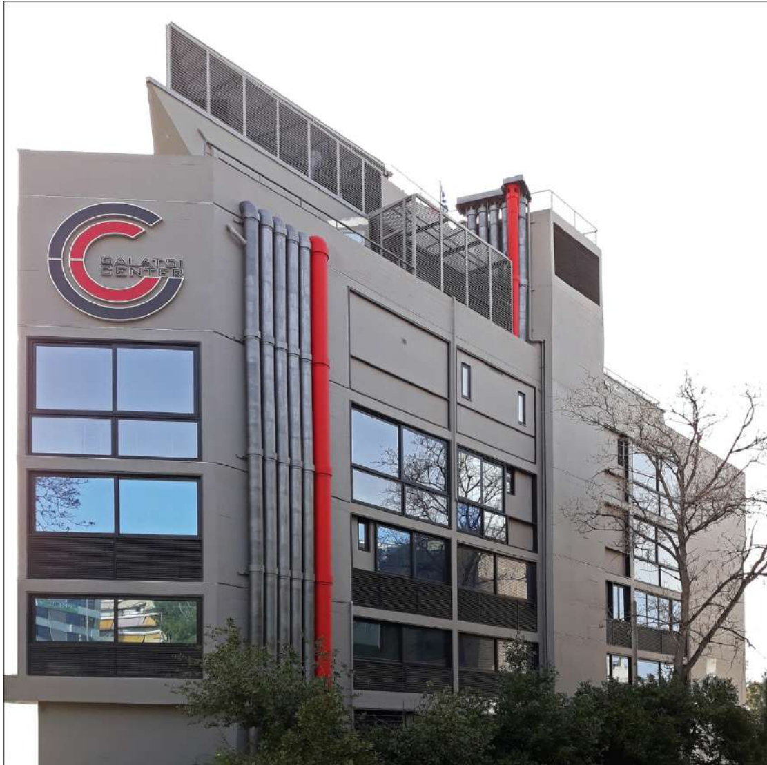
Εικ. 37-40. Πρόσφατες απόψεις του κτιρίου. [Πηγή: φωτ. Πάνος Εξαρχόπουλος, 4-4-2021]
